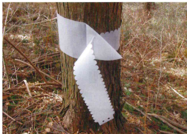
1本出し施工例
